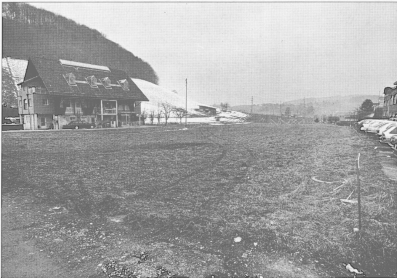
Nächste Woche beginnen hier die Arbeiten für ein Mehrfamilienhaus, welches gemeinsam von Behinderten und Nicht-Behinderten bewohnt werden wird. Mit dem Projekt taten sich die Behörden schwer. (Bild: P. Zaugg)
